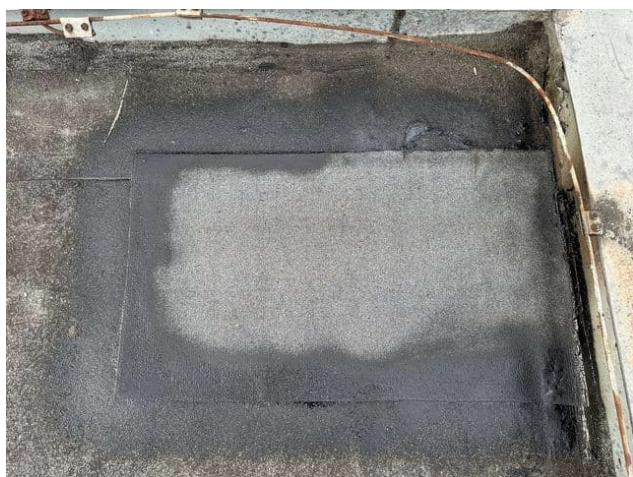
foto /50/ Pohled na zapravení sondy S6 – spodní pás
